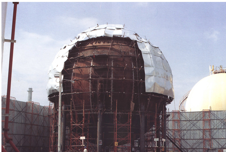
Figura 21 - Fabricação de vaso esférico - fase 4: esfera já com todos seus gomos montados, a partir desta fase, tem-se: furações, montagem de acessórios, PWHT, pintura e teste hidrostático (UNIMIT ENGINEERING, 2011).
