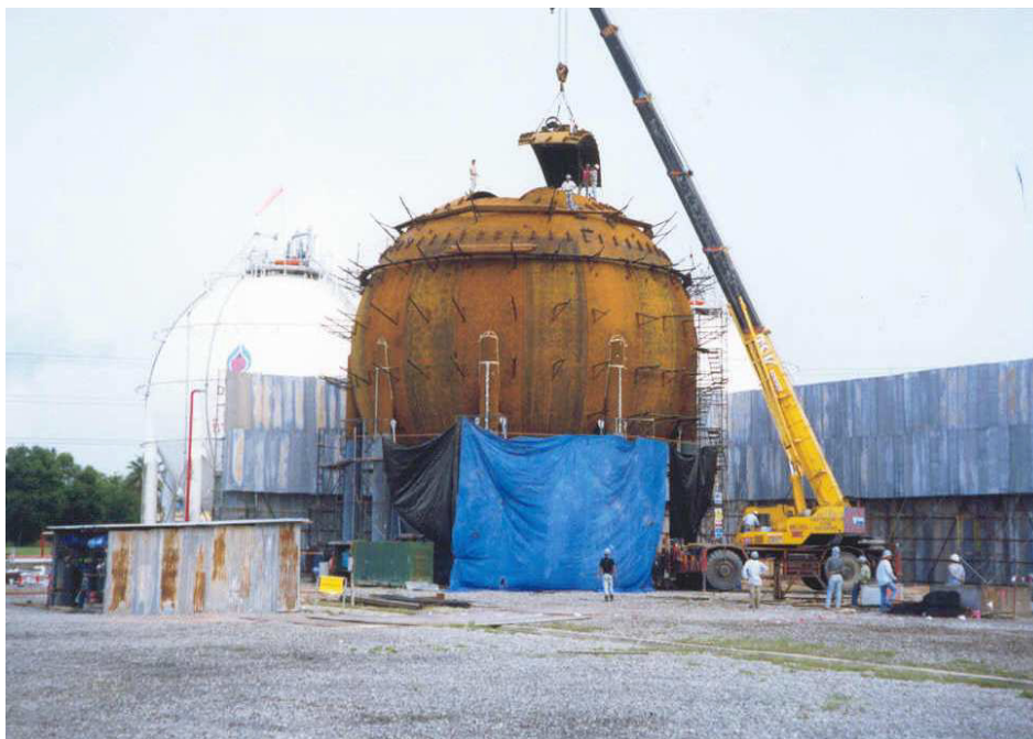
Figura 20 - Fabricação de vaso esférico - fase 3: montagem das tampas inferior e superior (UNIMIT ENGINEERING, 2011).
