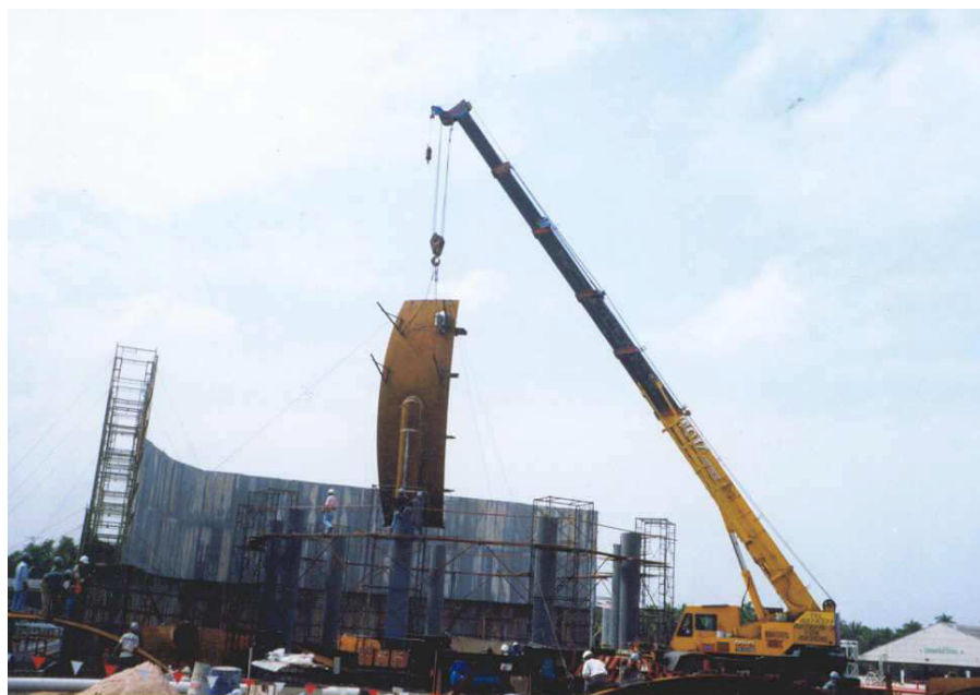
Figura 18 - Fabricação de vaso esférico - fase 1: fundação das parte inferior das colunas, colocação de andaimes e início da fixação dos gomos do Equador (UNIMIT ENGINEERING, 2011).
